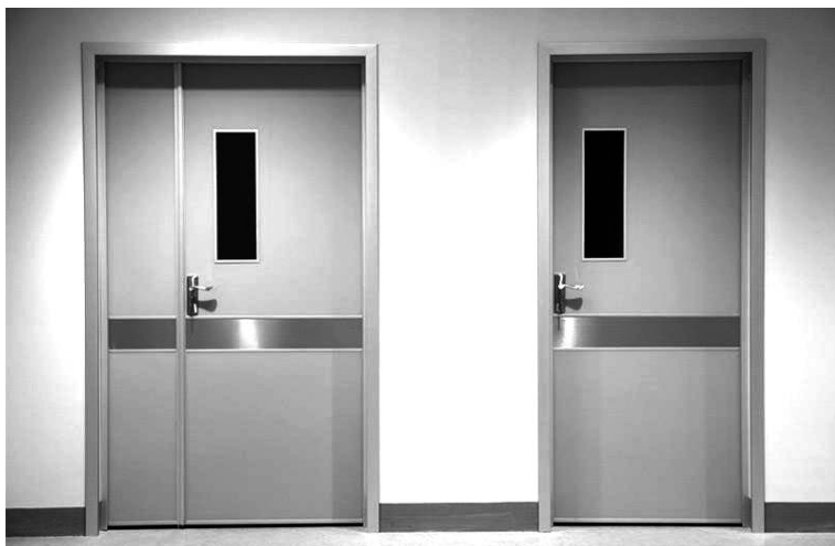
شکل ۲-۵: درهای مقاوم در برابر حریق
