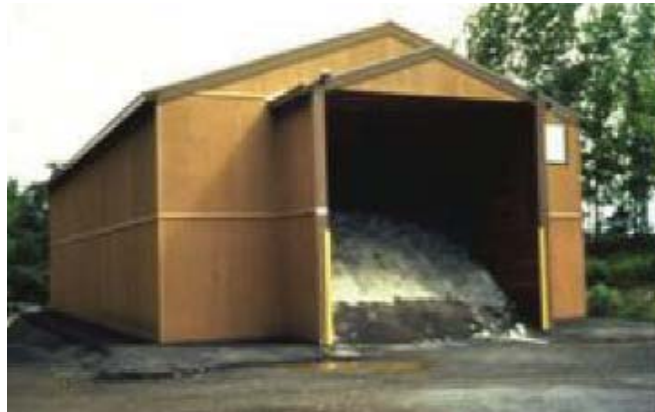
شکل ۶-۷: انبار چوبی با درب از جلو.
