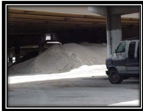
شکل ۹-۱۱: نمایی از انبار نمک در مجاورت ستون‌های پل.
