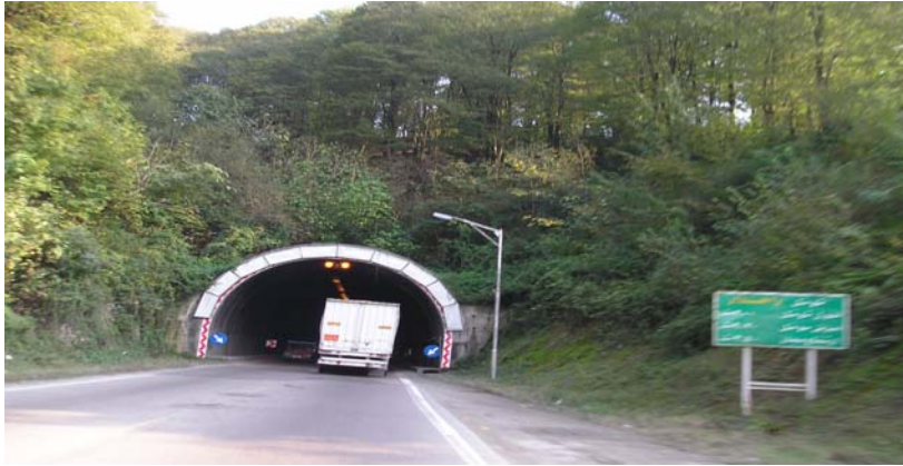
شکل ۳-۵: آگاه سازی رانندگان از وجود تونل و آشکارسازی ورودی تونلها از نظر ایمنی لازم و ضروری است. تیم بازرسی باید در مراحل بازرسی با دقت این موضوع را مورد بررسی قرار دهد.
