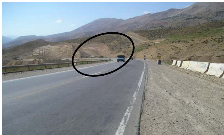
شکل ۷-۸۱: قرارگیری محل عملیات در بعد از قوس، که رانندگان بدون اطلاع قبلی و سرعت عادی به منطقه وارد می‌شوند و برای آنها خطرناک است.
