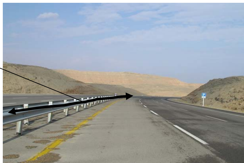
شکل ۷-۷۳: وجود پیچ تند در مسیر و عدم نصب بال کبوتری بر روی گاردریل، قابلیت دید آن در شب راکاهش داده و باعث برخورد وسایل نقلیه با گاردریلها می‌شود.
