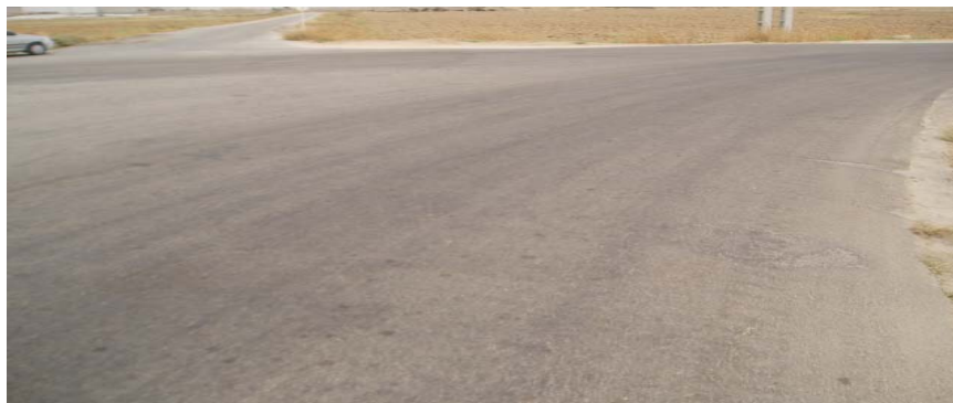
شکل ۶-۲: عدم وجود خط‌کشی در دماغه ورودی باعث سردرگمی راننده می‌شود.
