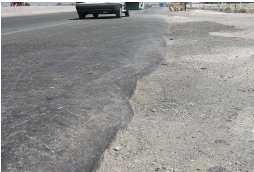
شکل ۳-۷: افتادگی شدید شانه در کناره‌های راه از جمله مسائلی است که در بازرسی ایمنی راههای موجود باید در نظر گرفته شود. در تصویر مقابل افتادگی شانه به اندازه‌ای است که در صورت انحراف وسیله نقلیه احتمال واژگون شدن آن وجود دارد.
