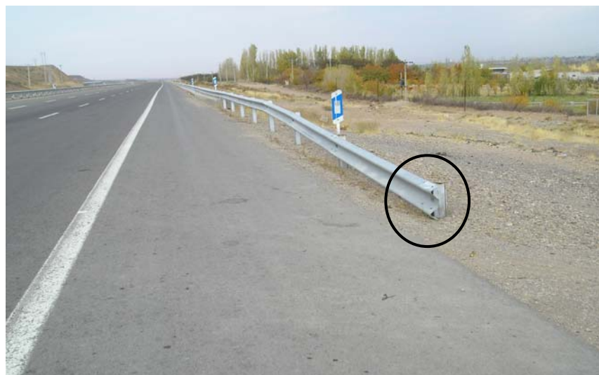
شکل ۷-۶۲: ایمن سازی نامناسب انتهای گاردریل ها، در محل قبل از آبروها، که خطر برخورد وسایل نقلیه منحرف شده با این نقطه (که خطرناک نیز هست) وجود دارد.
