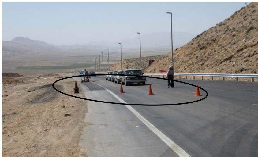
شکل ۷-۸۰: استفاده از مخروطی‌های کثیف و کهنه در منطقه عملیاتی که قابلیت دید پایینی داشته و برای هدایت و هشدار به رانندگان مناسب نمی‌باشند.
