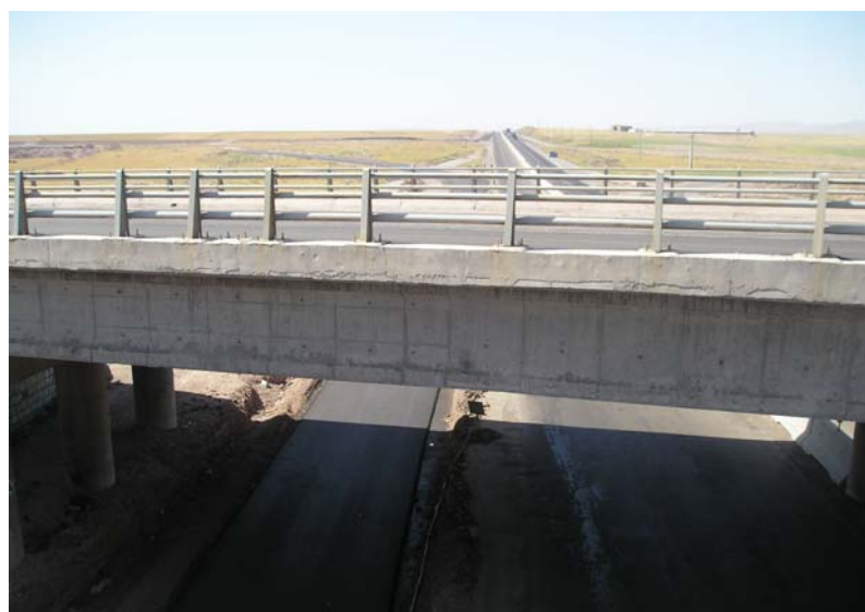
شکل ۷-۴۰: پایه پل روگذر آزادراه در محل تقاطع غیرهم سطح ((آقابابا)) که به عنوان مانع ثابت تلقی شده و باید محافظت شود.
