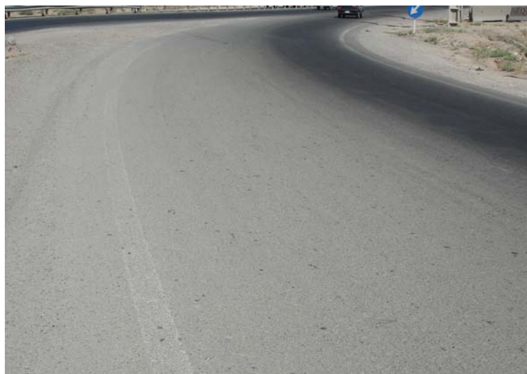
شکل ۷-۱۰۲: عدم وجود خط‌کشی مناسب در رمپ ورودی از آزادراه که تشخیص مسیر حرکت را مشکل می‌نماید.
