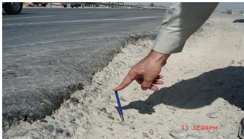
شکل ۷-۱۱۱: افتادگی بیش از حد شانه در محل دوربرگردان غربی که باعث می‌شود وسایل نقلیه سنگین با چندین بار حرکت عقب و جلو موفق به دور زدن شوند.
