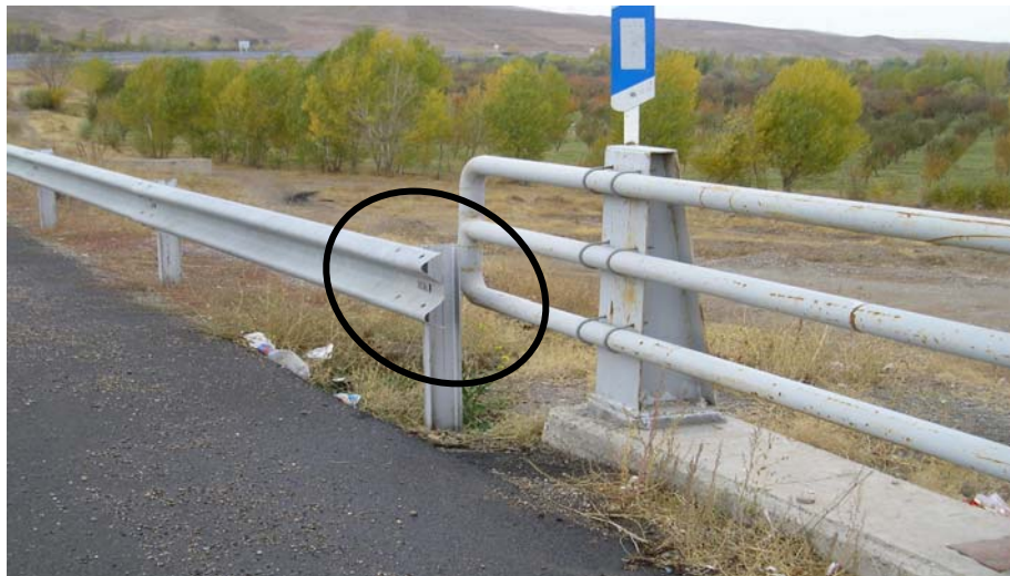
شکل ۶۶-۷: عدم وجود ایمن سازی انتهای گاردریلها در محل اتصال آنها به نرده پلها، در جهت ترافیک که خطر ثابت برای رانندگان به شمار می آید.
