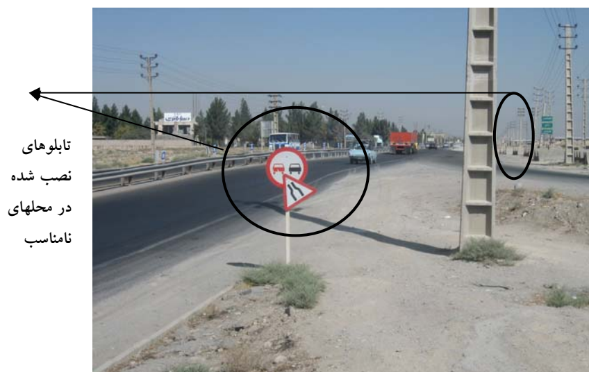
شکل ۷-۱۱۳: جانمایی نامناسب تابلوهای سبقت ممنوع و جاده باریک می‌شود.
