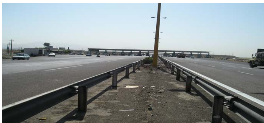
شکل ۳-۱۷: میانه‌ها یکی از مهمترین مواردی است که در ایمنی تاثیر داشته و در بازرسی ایمنی آزادراه و بزرگراه نوع حفاظ، عرض میانه استفاده شده برای میانه و آشکارسازی آن ارزیابی شود.
