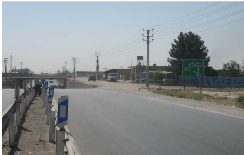
شکل ۷-۹۹: عدم وجود خط‌کشی در طول محور برای نشان دادن مسیر حرکت، که خصوصاً در شب، خطرناک است.
