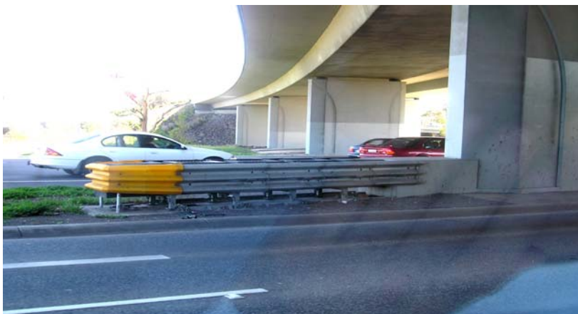
شکل ۳-۶: پایه پلهای روگذر یک مانع ثابت برای راه زیر گذر به شمار می‌رود. بازرسان پیش از گشایش این موضوع را بررسی کرده و از لحاظ ایمنی نحوه ایمن‌سازی آن را ارزیابی می‌کنند.
