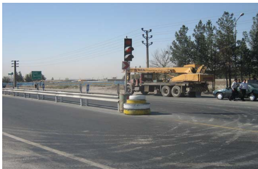
شکل ۷-۹۰: ایمن سازی نامناسب انتهای گاردریلها در محل دوربرگردان شرقی
