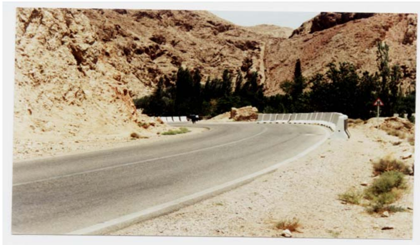
شکل ۳-۳: در تصویر نشان داده شده برای جلوگیری از خروج وسایل نقلیه از نیوجرسی استفاده شده است در حالی که آنها مهار انتهایی نداشته و آشکارسازی هم نشده‌اند.
