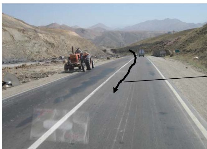
شکل ۷-۸۲: قرارگیری محل عملیات در بعد از قوس، که رانندگان بدون اطلاع قبلی و سرعت عادی به منطقه وارد می‌شوند و برای آنها خطرناک است.
