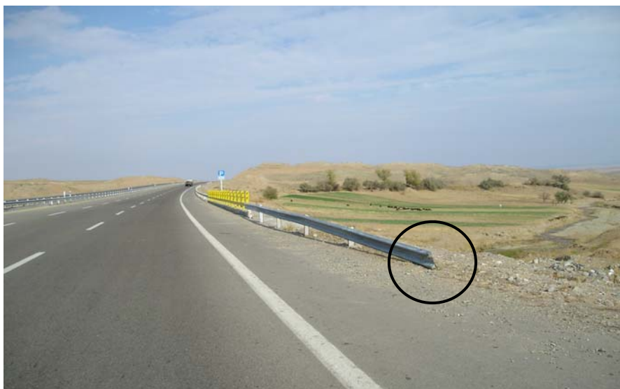
شکل ۶۱-۷: ایمن سازی نامناسب انتهای گاردریل ها در محل قبل از آبروها، که خطر برخورد وسایل نقلیه منحرف شده با این نقطه (که خطرناک نیز هست) وجود دارد.
