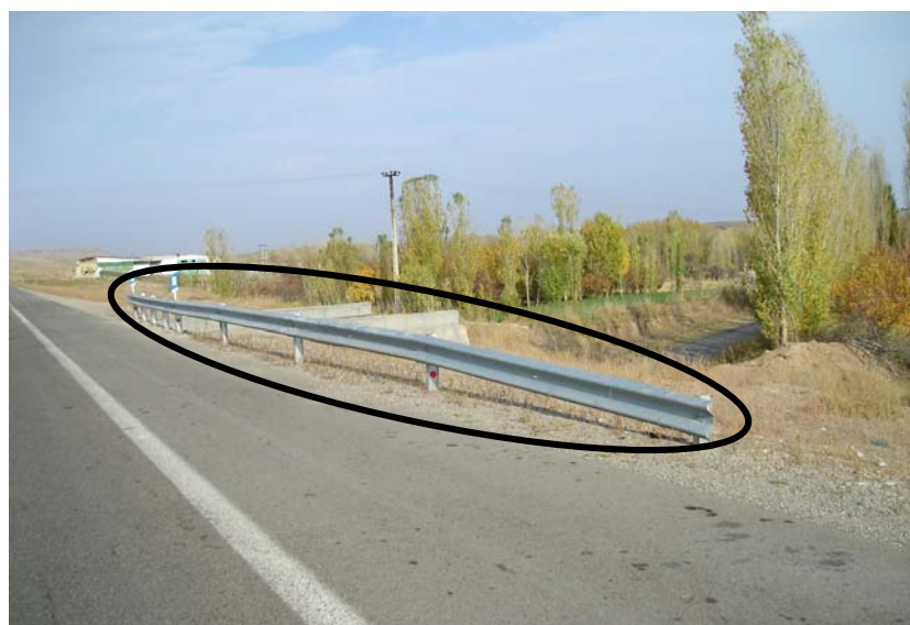
شکل ۷-۶۳: طول کم گاردریل نصب شده در روی جانپناه پل که در صورت سقوط وسیله نقلیه عملکرد مناسب ران خواهد داشت.
