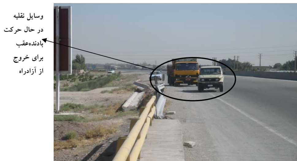
شکل ۷-۹۶: عدم نصب تابلوهای لازم جهت نشان دادن خروجی آزادراه که باعث سردرگمی رانندگان شده است.
