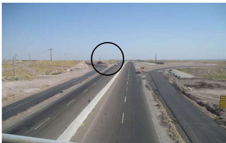
شکل ۷-۴۶: وجود تپه خاکی در محل لوپ ورودی از آزادراه به بزرگراه (مانع دید)
