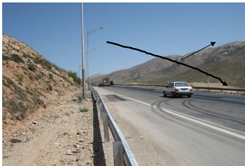
شکل ۷-۷۵: عدم استفاده از تابلوهای اطلاعاتی لازم در منطقه عملیاتی به خصوص در تاج قوس که محدودیت دید نیز وجود دارد.
