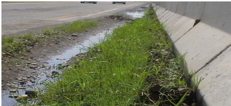
شکل ۲-۱۰: در مناطقی که بارندگی در بیشتر روزهای سال وجود دارد (مانند شمال کشور) بررسی وضعیت زهکش‌های حاشیه راه برای جلوگیری از آبگرفتگی راه در شرایط بارندگی یکی از مواردی است که باید توسط بازرسان کنترل شود.
