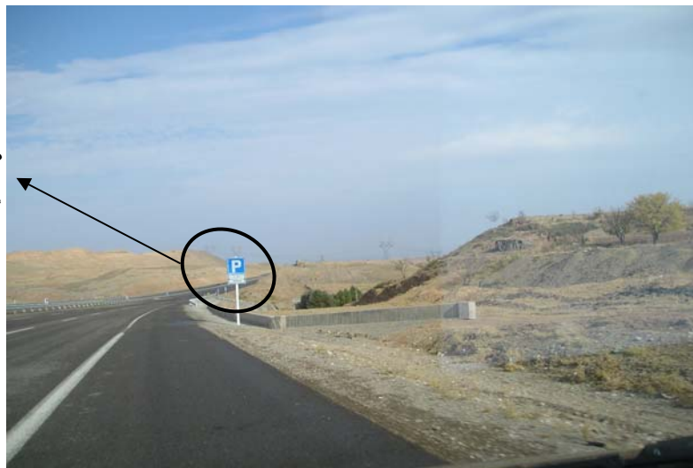
شکل ۷-۷۲: اندازه نوشته‌های ریز متمم تابلوهای پارکینگ نصب شده در مسیر که باتوجه به سرعت حرکت وسایل نقلیه کوچک و نامناسب است.
