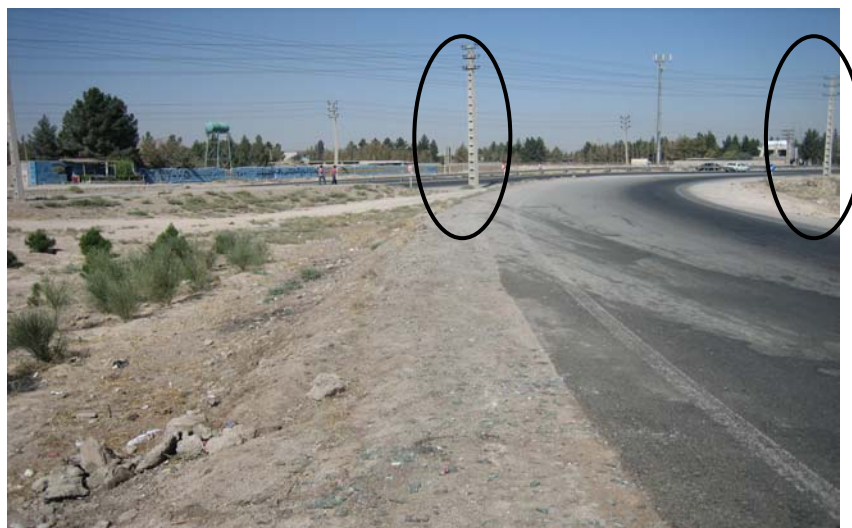
شکل ۷-۸۹: تیرهای انتقال برق محافظت نشده در محل رمپ ورودی به راه اصلی که مانع ثابت می‌باشند.
