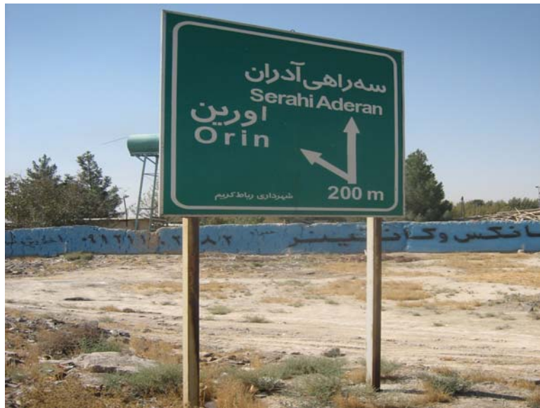
شکل ۷-۱۱۵: تابلوی اشتباه نصب شده در باند غربی زیرگذر که باعث سردرگمی رانندگان می شود.
