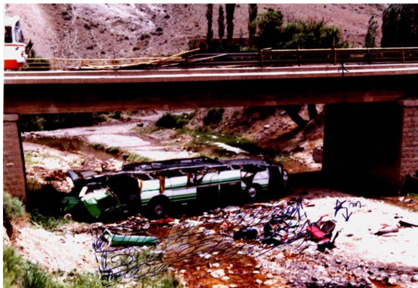
شکل ۲-۲۰: سقوط یک دستگاه اتوبوس از پل به علت عدم استحکام کافی نرده پل بازرسی ایمنی = پیشگیری از وقوع تصادف
