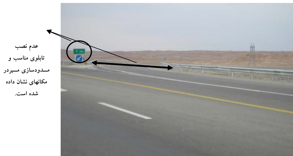
شکل ۷-۵۹: مسیر عبوری به قطعه در دست احداث آزادراه تبریز زنجان که به خاطر عدم مسدود شدن مسیر و نصب تابلوهای لازم، باعث سردرگمی رانندگان می شود.
