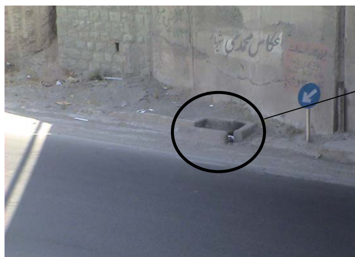
شکل ۷-۱۰۷: انباشتگی زهمکش‌های زیر پل و عملکرد نامناسب آنها که به هنگام بارندگی مشکل ساز می‌باشد.
