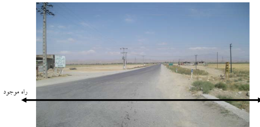
شکل ۷-۵: راه آسفالتی موجود برای روستای زیارت که در طراحی در نظر گرفته نشده است
