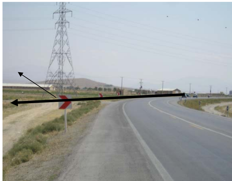
شکل ۷-۱۴: وجود دکل‌های بزرگ برق در منطقه شروع کنارگذر و لزوم در نظر گرفتن تمهیدات لازم برای حفظ حریم ۱۰۰ متری دکل‌ها
