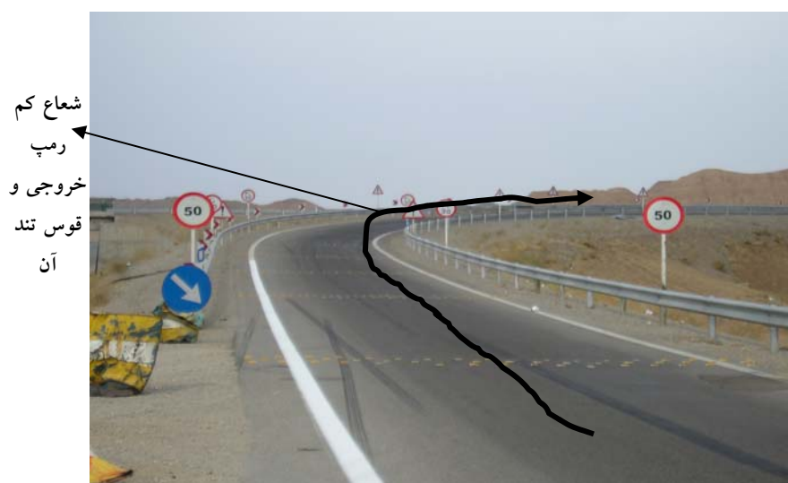
شکل ۷-۶۴: طرح هندسی نامناسب خروجی مورد استفاده در انتهای آزادراه ظرفیت لازم برای عبور ترافیک را ندارد.
