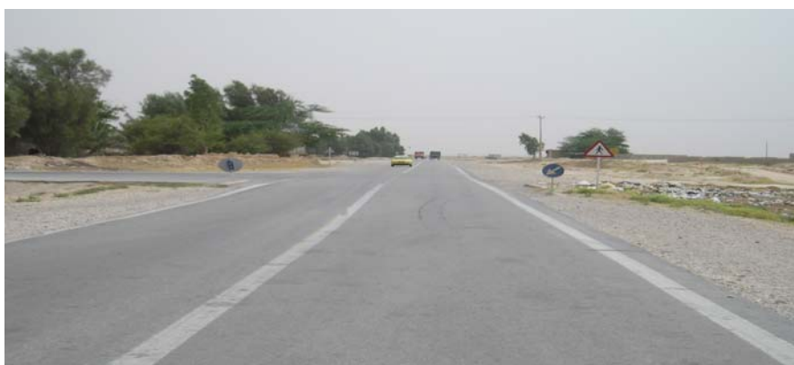
شکل ۲-۲: عرض کم شانه روسازی شده که در بازرسی مرحله دوم می‌توان با بررسی مقاطع عرضی پیشنهادی طراح از ایجاد چنین مشکلی جلوگیری کرد.
