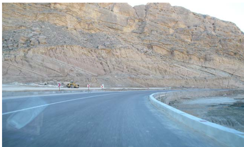
شکل ۴-۲: در تصویر نشان داده شده برای جلوگیری از سقوط وسایل نقلیه به داخل رودخانه در حاشیه سمت راست از جانپناه استفاده شده است. ولی جانپناه آن نه آشکارسازی شده و نه حفاظ‌گذاری لازم انجام گرفته است.
