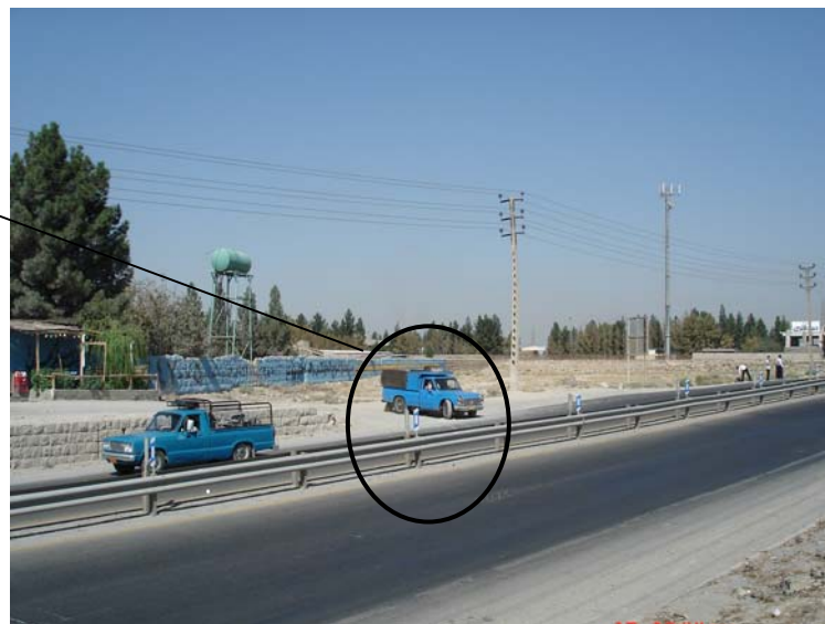
شکل ۷-۱۰۰: دورزدنهای غیرمجاز که باعث ایجاد تداخل در حرکت شده عدم وجود روشنایی در شب مشکل ساز است.
