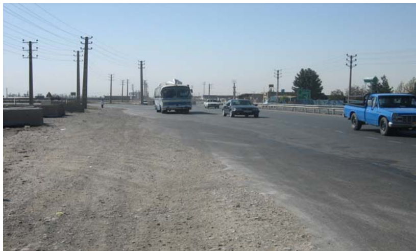
شکل ۷-۱۰۳: تداخل وسایل نقلیه در محل همگرایی ترافیک عبوری از راه اصلی و ورودی از آزادراه که در آن احتمال برخورد وسایل نقلیه وجود دارد.
