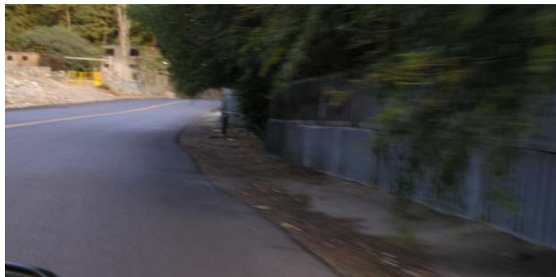
شکل ۳-۲۰: منظر آرایشی حاشیه راه از جمله مواردی است که با ایجاد محدودیت دید می‌تواند باعث بروز خطر برای رانندگان شود. در تصویر، عدم وجود فاصله دید مناسب در اثر وجود شاخ و برگ درختان مشاهده می‌شود.
