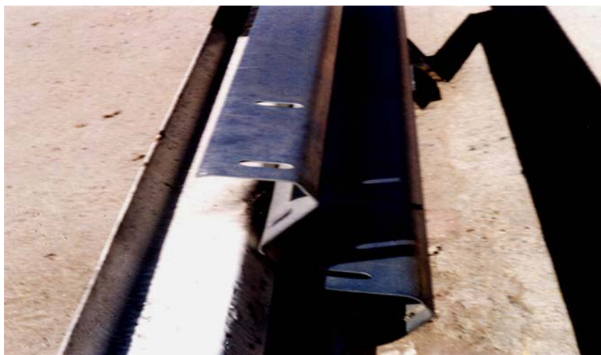
شکل ۱-۳: همپوشانی گاردریلها در محل اتصال گاردریل باید در بازرسی ایمنی راه‌های موجود و پیش از گشایش مورد توجه بازرسان قرار گیرد.
