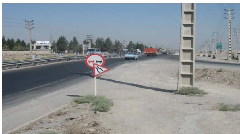
شکل ۳-۹: علایم عمودی یکی دیگر از پارامترهای تاثیرگذار در ایمنی جاده می‌باشد که به کارگیری مناسب آن در کاهش حوادث، مفید خواهد بود. در تصویر نشان داده شده تابلوهای اشتباه که در محل نامناسبی نیز قرار داده شده‌اند باعث سردرگمی رانندگان خواهد شد.
