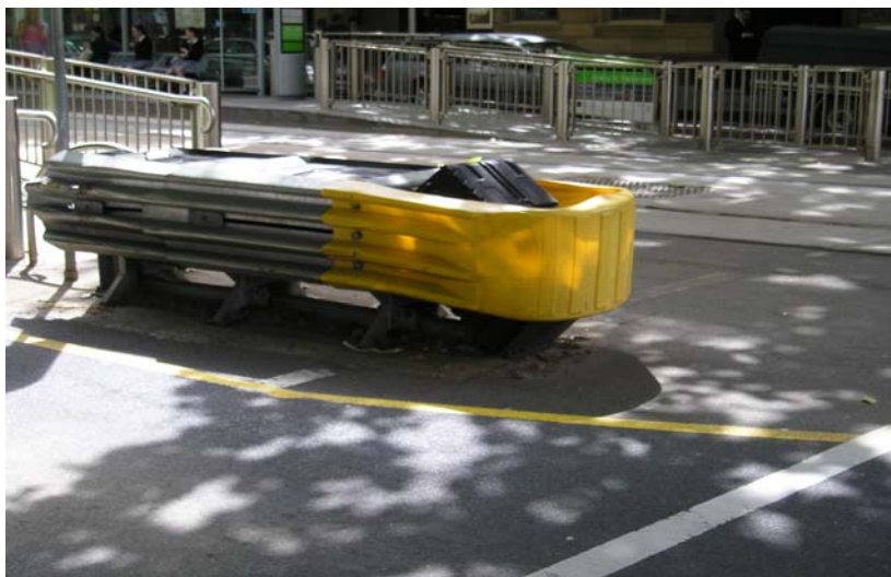
شکل ۳-۱۲: استفاده از تجهیزات ایمنی مناسب بویژه در دماغه ورودی و خروجی‌ها یکی از مواردی است که ایمنی مسیر را افزایش می‌دهد.
