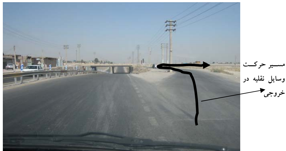
شکل ۷-۱۰۱: طرح هندسی نامناسب و وجود موانع فیزیکی خطرناک در رمپ خروجی راه اصلی
