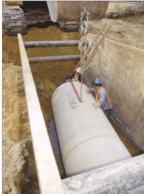
شکل ۳-۱- رعایت ایمنی در حفاری ترانشه
