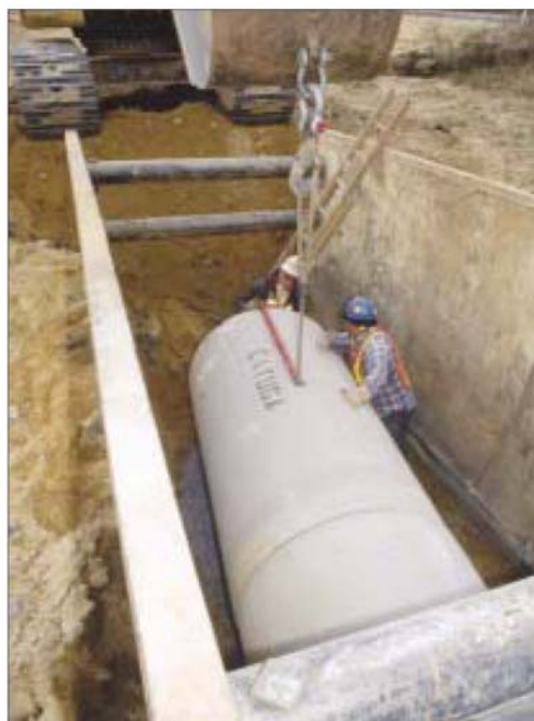
شکل ۳-۱- رعایت ایمنی در حفاری ترانشه
