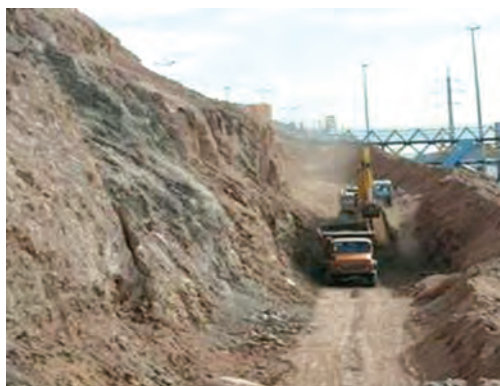
شکل ۱- اجرای عملیات خاک‌برداری
