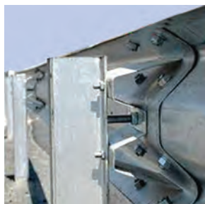
شکل ۱۴- پیچ مرکزی
