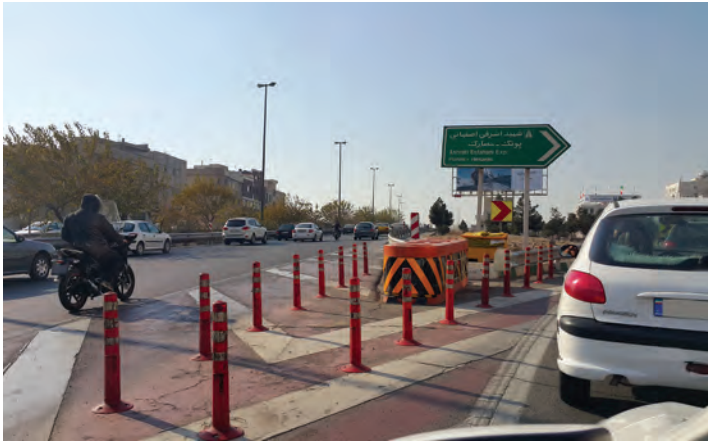
شکل ۱۷-ب) محل قرارگیری ضربه‌گیرهای بشکه‌ای در ناحیه دماغه راه
