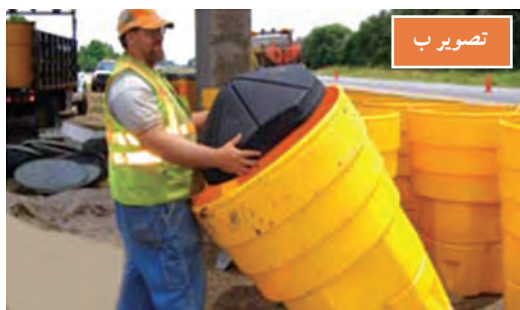
شکل ۲۲- چیدمان بشکه‌ها و قرار دهی مخروط درونی
