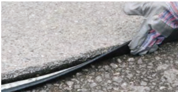
شکل ۴۸- نصب نوار لکه‌گیری بر روی دیواره آسفالت
