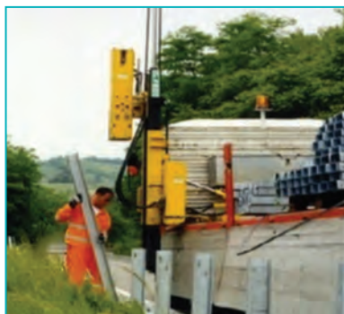
شکل ۳۴- چکش هیدرولیکی گاردریل کوب
