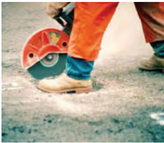
شکل ۴۲- دستگاه برش محل خرابی و تراکم کننده دستی
