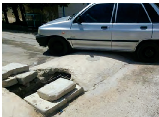
شکل ۹- ساخت سرعت‌گیر غیر استاندارد بتنی و آسفالتی
