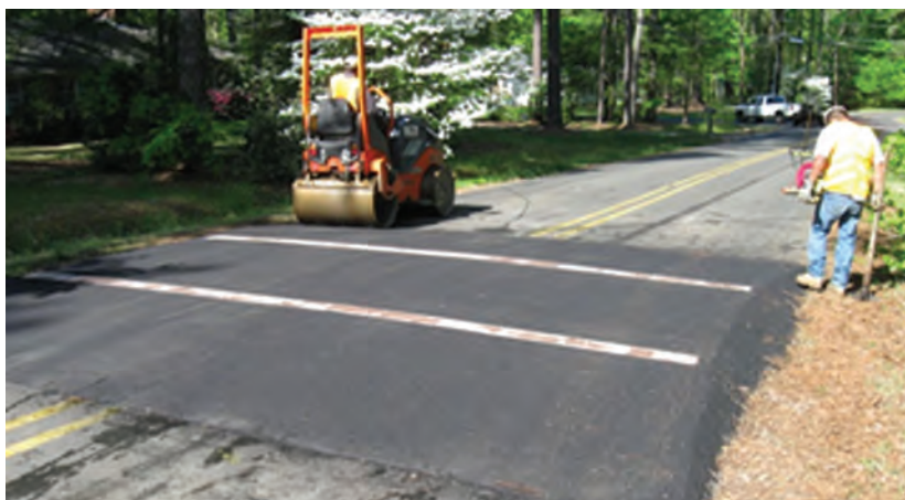
شکل ۲۴- غلتک زدن سطح سرعت گاه
