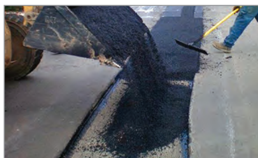
شکل ۴۰- روش ریختن و غلتک زدن
