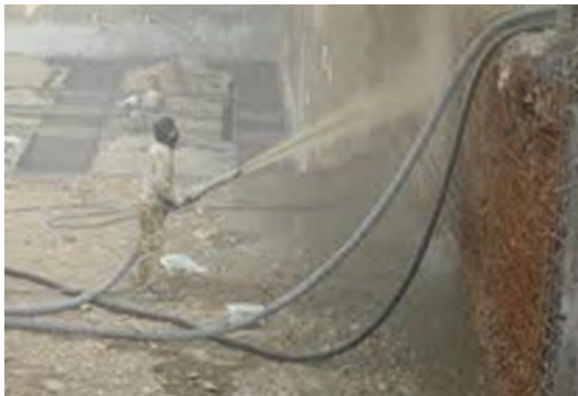
شکل ۲۰- اجرای بتن پاشی (شاتکریت) در بدنه سد
