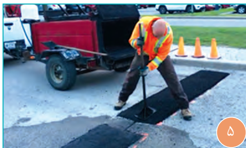
شکل ۷- مراحل اجرای سرعت گیر آسفالتی
