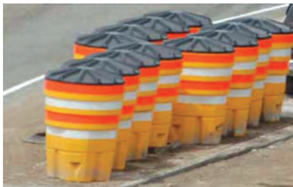
شکل ۲۷- طریقه نصب و چیدمان صحیح ضربه‌گیرهای بشکه‌ای
