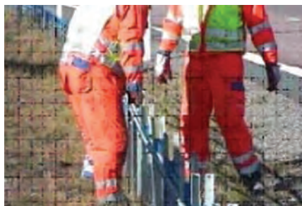
شکل ۶۷- تعمیر حفاظ کابلی
