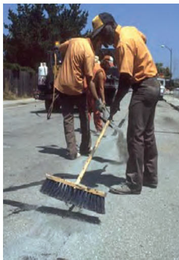
شکل ۳۴- استفاده از جارو برای پخش ماسه بر روی ماده درزگیر ترک اشتباه است
