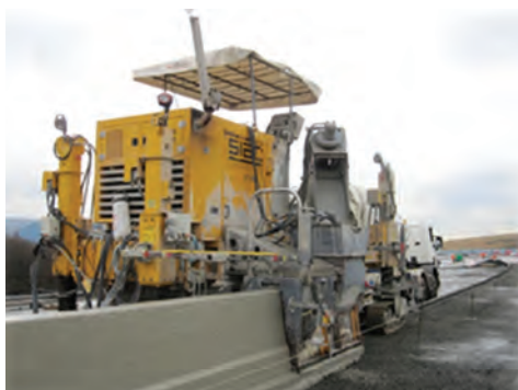
شکل ۵۰- ساخت نیوجرسی (بتن درجا به روش اتوماتیک)
