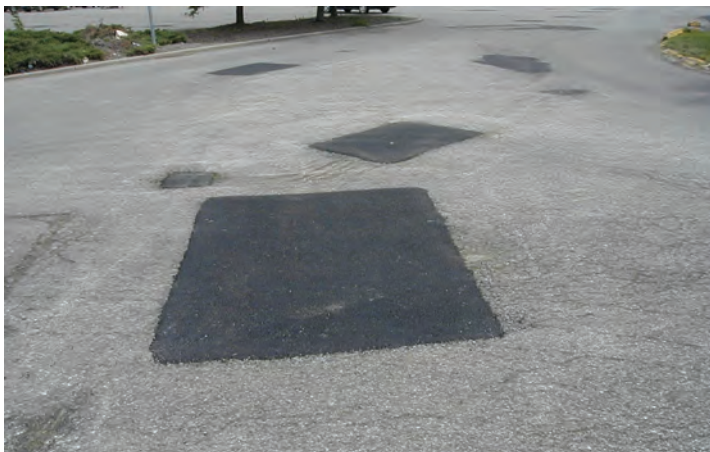
شکل ۹- نمونه‌ای از لکه‌گیری در روسازی آسفالتی
