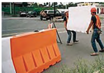
شکل ۳۰- حمل حفاظ پلاستیکی برای نصب در مسیر
