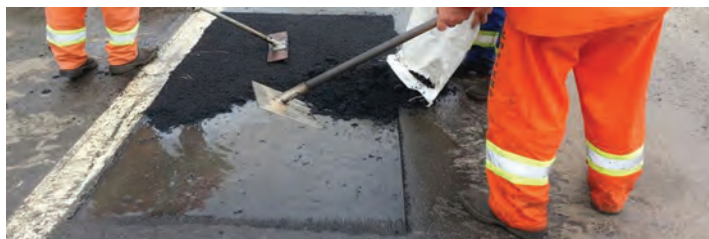
شکل ۳۶- عملیات لکه‌گیری
