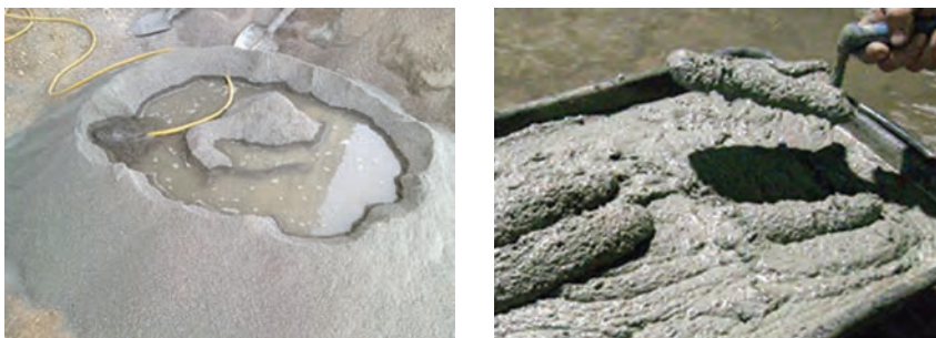
شکل ۱۸- طرز تهیه ملات ماسه سیمان
