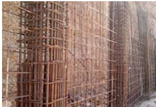
شکل ۲۰- اجرای بتن پاشی (شاتکریت) در بدنه سد
