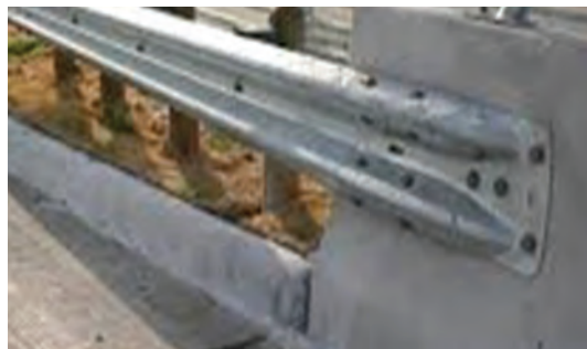
شکل ۸۱ - ناحیه انتقالی حفاظ دو موج به نیوجرسی
