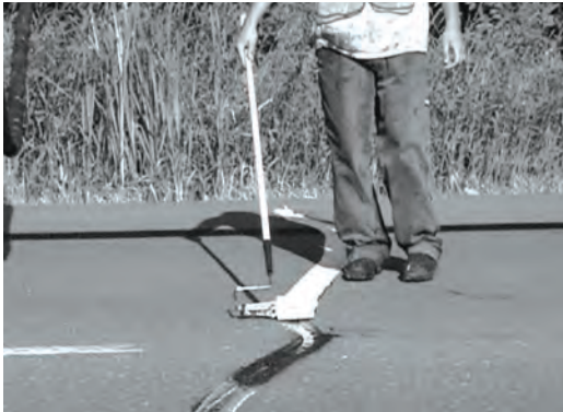
شکل ۳۰- استفاده از دستمال کاغذی به عنوان پوشش موقت ماده درزگیر
