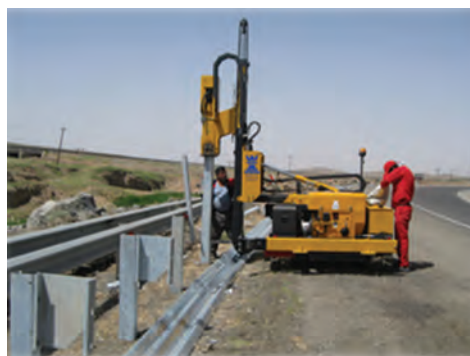
شکل ۴۴- پایه کوبی، نصب لقمه
