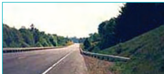
شکل ۷۴- بالی شکل کردن و فرو بردن انتهای حفاظ در شیروانی راه
