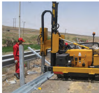
شکل ۴۲- پایه‌کوبی بعد از ریلی کردن سپری‌ها
