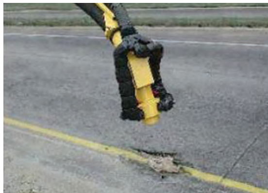
شکل ۴۵ - تمیز نمودن چاله جهت ترمیم با فشار هوا
