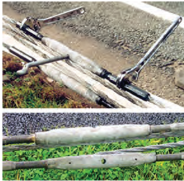
شکل ۴۸ - تنظیم کشش کابل
