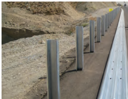
شکل ۴۲- پایه‌کوبی بعد از ریلی کردن سپری‌ها
