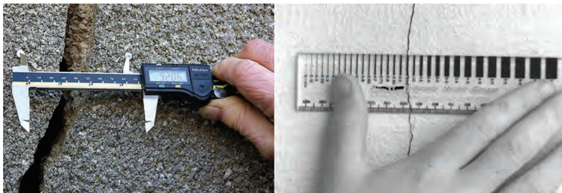
شکل ۱۶- نحوه اندازه‌گیری عرض ترک با استفاده از خط‌کش مدرج یا کولیس
