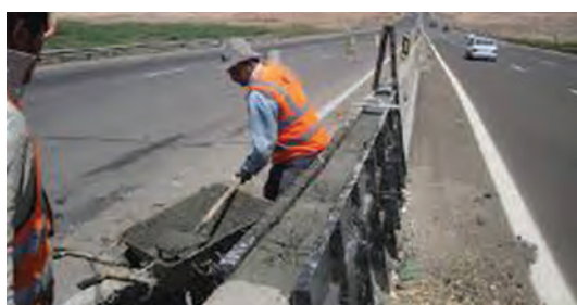
شکل ۲۳- تعمیر حفاظ بتنی (نیوجرسی) در محل
