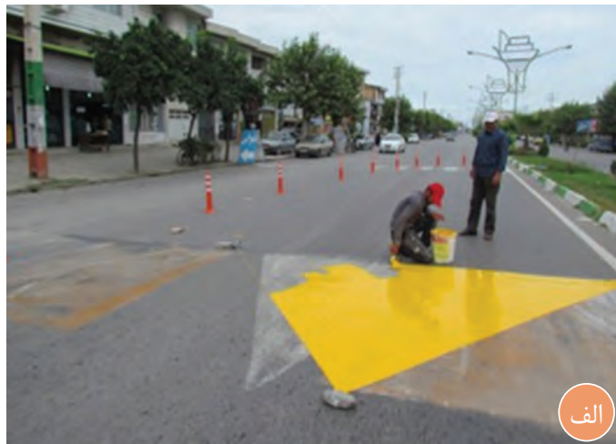
شکل ۲۷ - رنگ‌آمیزی سطح روسازی
