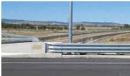
شکل ۸۲ - ناحیه انتقالی حفاظ سه موج به نیوجرسی
