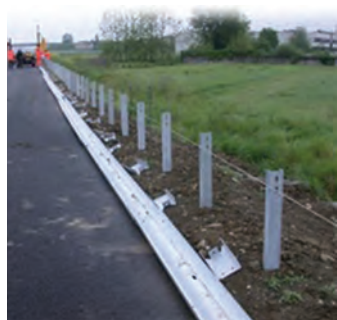
شکل ۴۳- نمونه‌ای از نصب پایه‌های گاردریل با ریسمان‌کشی
