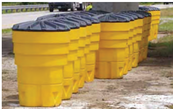
شکل ۲۷- طریقه نصب و چیدمان صحیح ضربه‌گیرهای بشکه‌ای
