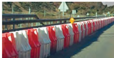
شکل ۲۹- حفاظ پلاستیکی نصب شده در مسیر
