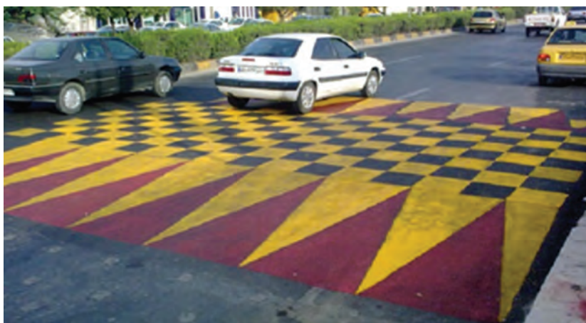
شکل ۲۵- نمونه‌ای از نحوه خط‌کشی سرعت‌کاه
