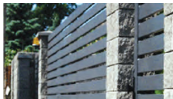
شکل ۱۱- دیوارهای حایل ژئوبلوک
