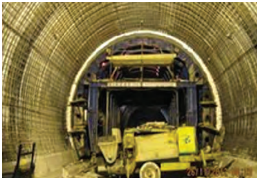
شکل ۲۱- اجرای بتن باشی (شاتکریت) در بدنه تونل نیایش تهران
