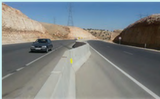
شکل ۵۵- وضعیت نیوجرسی بعد از تصادف با کامیون
