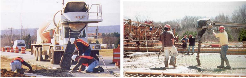
شکل ۲ ریختن بتن در نزدیکی محل مورد نیاز
