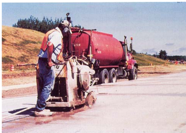
شکل ۱ استفاده از دستگاه برش برای ایجاد درز
