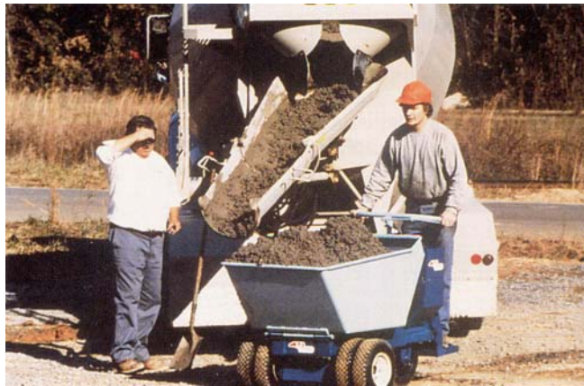
شکل ۲ انتقال بتن با استفاده از فرغون موتوری
