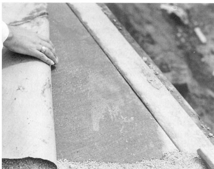
شکل ۳ عمل آوری عایقی (پوشش‌های مرکب)
