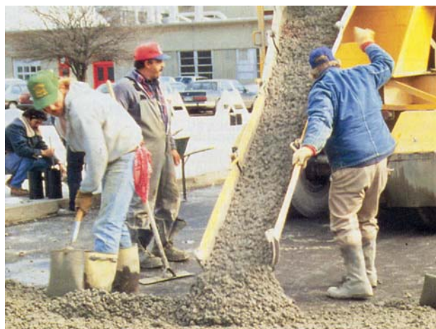
شکل ۴ انتقال بتن با استفاده از سطح شیبدار
