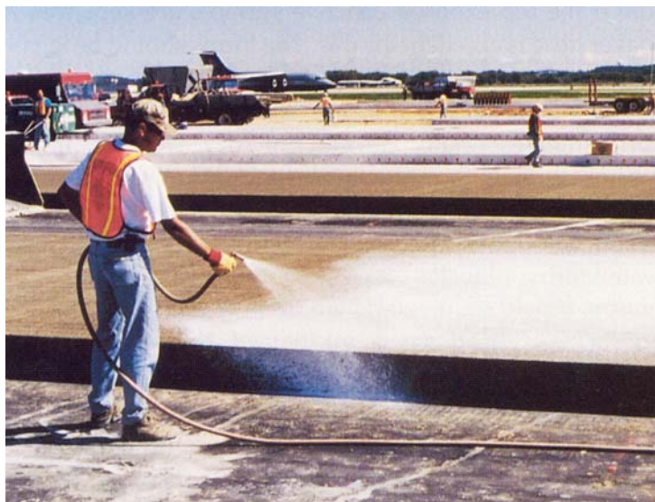
شکل ۴ روش عمل‌آوری با ماده شیمیایی غشایی
