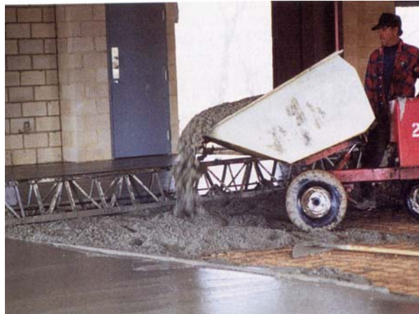
شکل ۳ روش صحیح ریختن بتن
