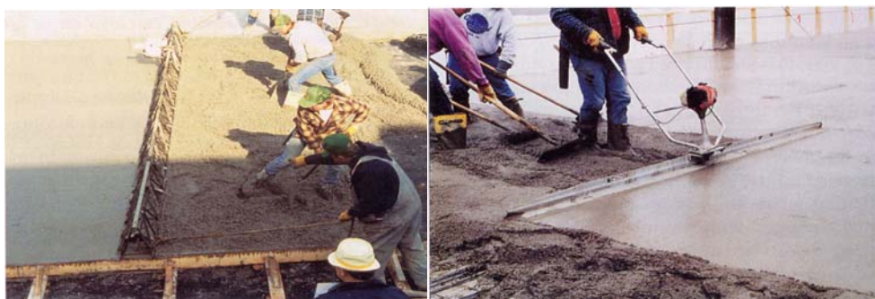
شکل ۲ استفاده از شمشه های دارای ویبره برای تراز کردن و متراکم نمودن سطح، به صورت همزمان
