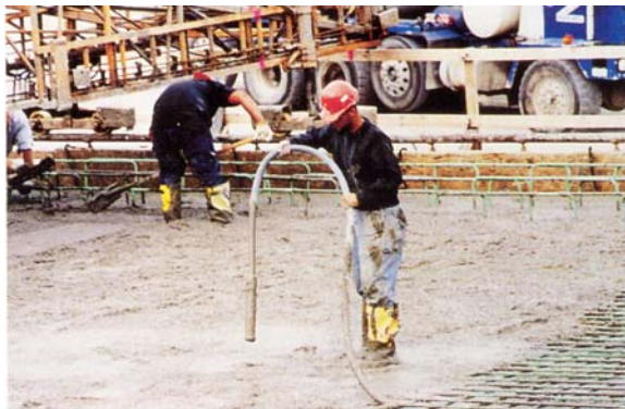
شکل ۴ همپوشانی، شعاع عمل ویبراتور و انجام شدن ویبره به صورت عمودی (تعیین فواصل نفوذ ویبراتور)
