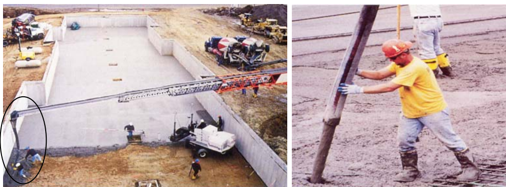
شکل ۵ - شوت قوطی، سمت راست انتقال بتن با استفاده از شوت سقوطی، سمت چپ ترکیب ناوه و شوت سقوطی
