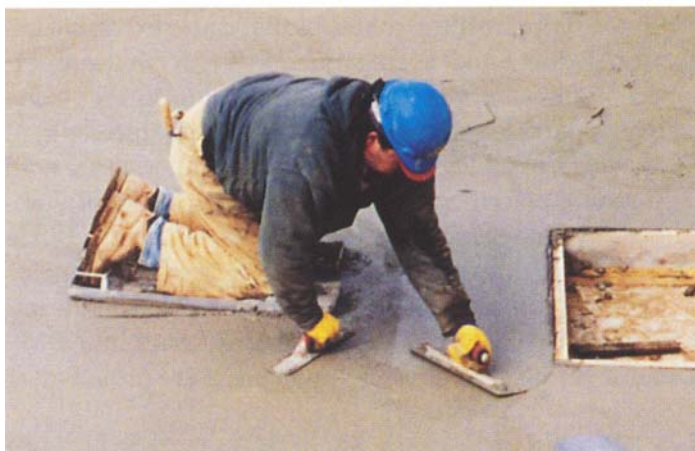
شکل ۵ پرداخت نهایی با ابزار دستی
