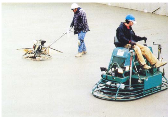
شکل ۶ پرداخت نهایی با ابزار مکانیکی
